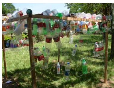
Figura 60-Processo de construção do “Recanto das emoções”
