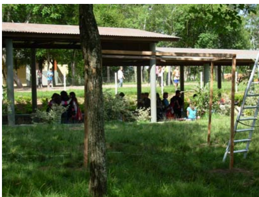
Figura 54 – Construção da estrutura de sustentação do “Recanto das emoções”
